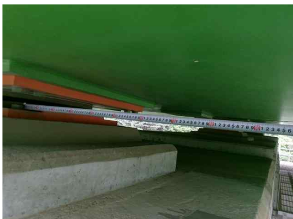
받침장치 연단거리 측정
